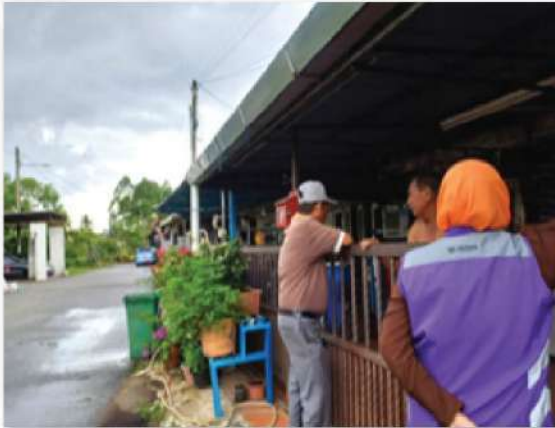
Binaan atas rizab jalan dan tambahan bumbung melebihi hak milik di Taman Seri Semangol
